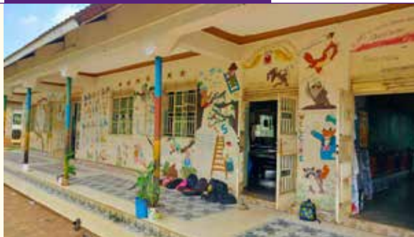
Nursery school (scuola dell'infanzia) aule e giardino
