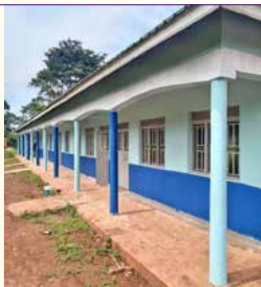
Novembre 2025 Struttura principale e bagni esterni
